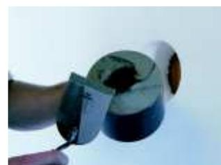
Premere il cilindro di montaggio MARCOTHERM ROUND-PU a filo dei pannelli nella sezione fresata.
