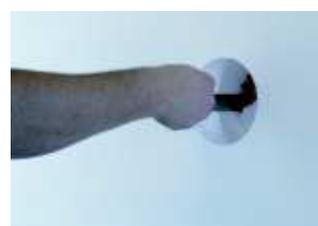
Applicare della malta adesiva sulla superficie circolare del cilindro di montaggio MARCOTHERM ROUND-PU. L'elemento deve essere completamente incollato su tutta la superficie della base.
