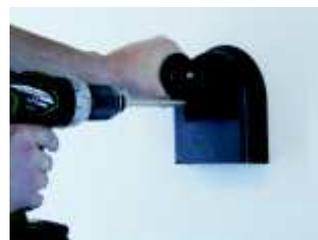
Eliminare lo spessore residuo utilizzando un utensile appropriato, e al termine dell'operazione rimuovere tutta la polvere di fresatura accumulatasi.
